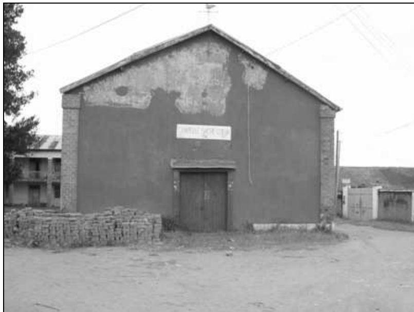
Photo. 1. La première chapelle d'Ampahateza, édifée en 1865, refaite en dur et devenue une « église » en 1868-69
